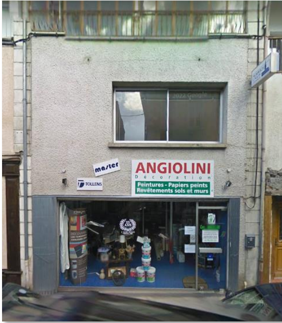
Transformation d'un rez-de-chaussée commercial en habitation
